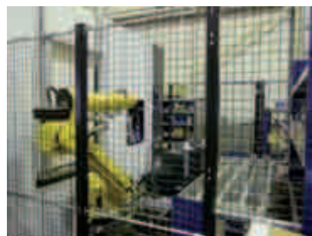
Deze robot is tussen twee bewerkingscellen geplaatst en kan deze be- en ontladen, en werkstukken van de ene machine naar de andere verplaatsen.
